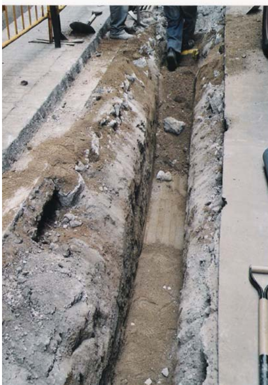
FOTO 3: Excavació manual a l'interior de la rasa 1.
