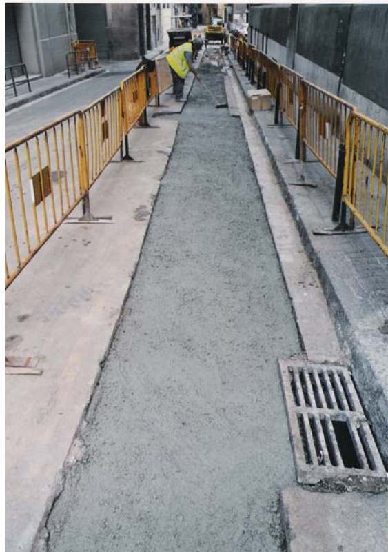
FOTO 8: Finalització dels treballs a la rasa 1.
