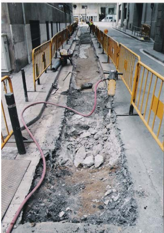
FOTO 1: Aixecament del paviment.
