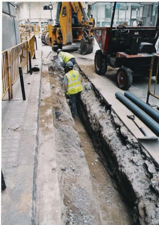
FOTO 2: Excavació de la rasa 1
