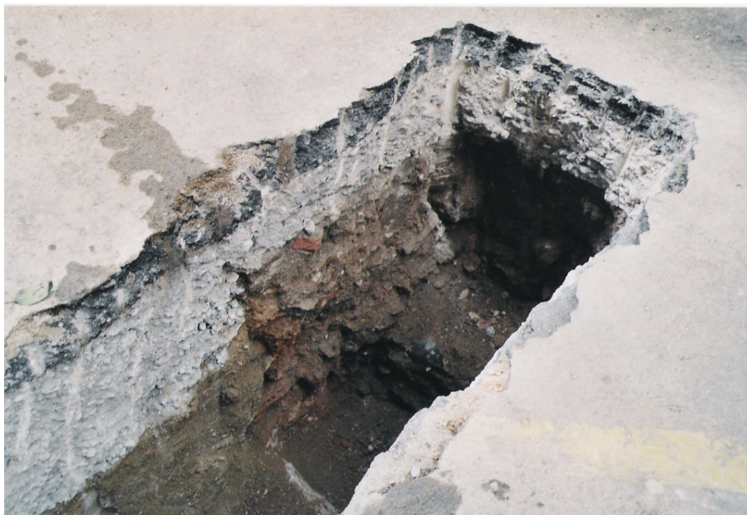
FOTO 7: Detall de l'interior de la rasa 1
