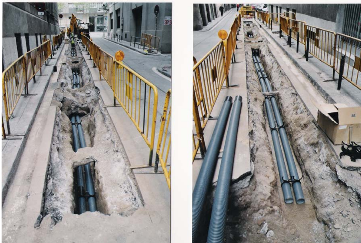
FOTO 5 I FOTO 6: Instal·lació dels serveis a l'interior de la rasa 1. vista des de l'est i l'oest respectivament
